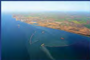
Les travaux de construction ont commencé au Danemark.
